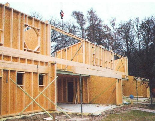
**Bild 8:** Teilvorgefertigte Holzfafelemente für die zweigeschossige Südfassade...
