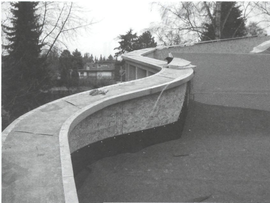
Anbringen der Attikaverblechung und Anschluss der Kunststoffabdichtungsbahn
