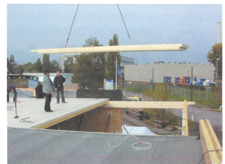
Bild 12: Dachelement der Ausstellungshalle mit Massiv-Einleimern am Auflager: Ausklinkung (rechts) und Auskragung (links).
