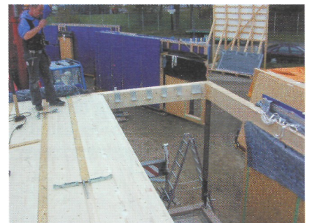
Bild 8: Die Geschossdecke wurde an den Randunterzug ebenengleich durch Stahl Z-Profile mit einer Lagesicherung durch Simplexverbinder angeschlossen.
