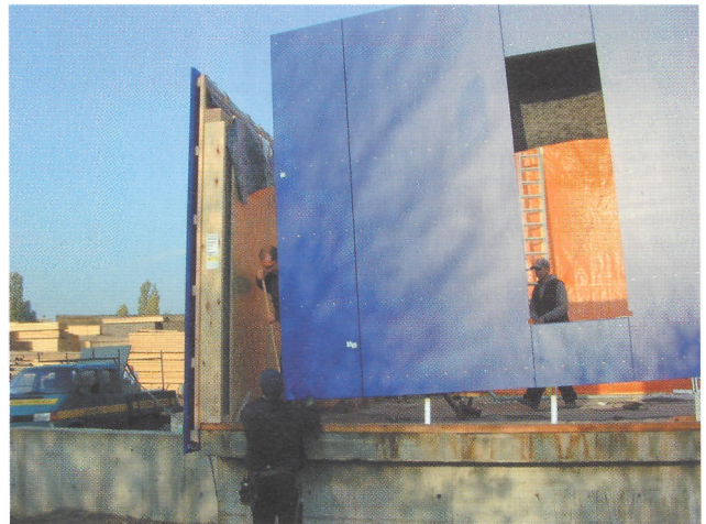
Bild 6: Die Außenwände des Verwaltungsgebäudes bestehen aus geschosshohen, 31 cm dicken, Holzrahmen-Elementen mit außenliegender Beplankung.
