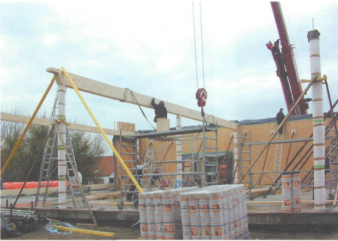
Bild 9: Auf- und Ausbau der Ausstellungshalle. Mittelfette mit auskragender Ausklinkung.
