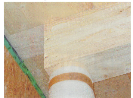
Bild 11: Die Auskragung der Pfette schließt bündig an die Untersicht der Dachflächelemente.
