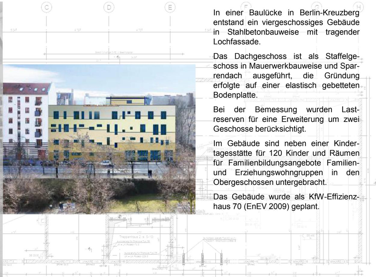
In einer Baulücke in Berlin-Kreuzberg entstand ein viergeschossiges Gebäude in Stahlbetonbauweise mit tragender Lochfassade.
