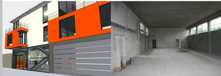
Der dreigeschossige Neubau in Berlin-Lichtenrade wurde in Massiv- und Stahlbetonskelettbauweise errichtet.
