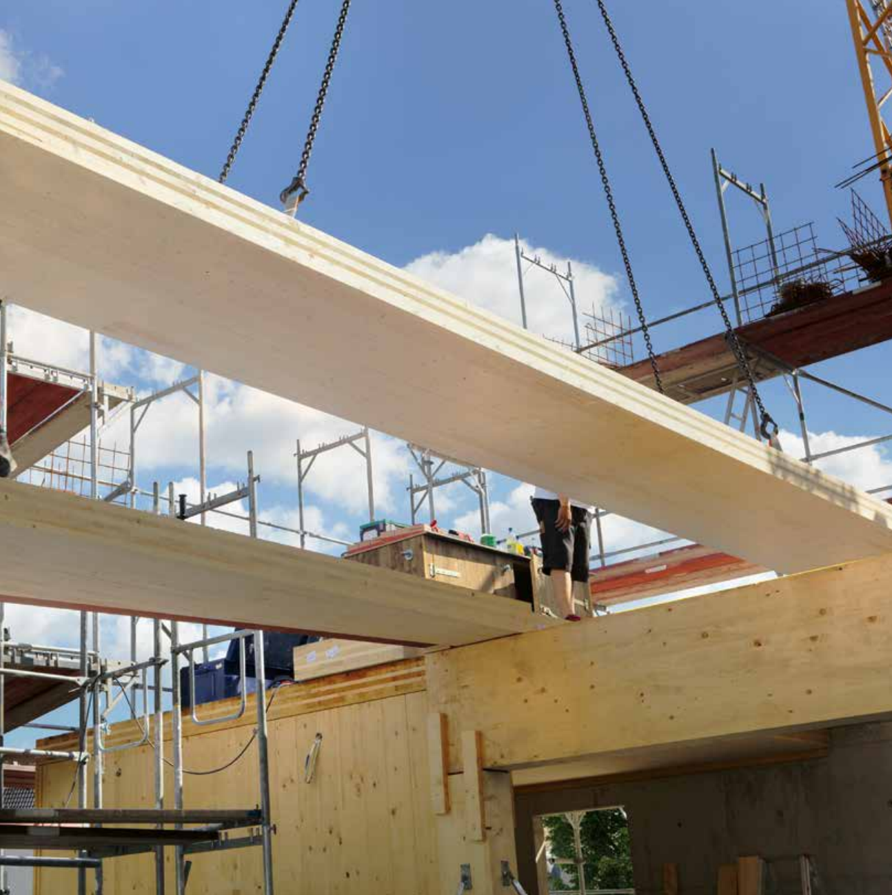
◀ Die Brettsperrholzplatten werden mit dem Kran an Ort und Stelle gehievt
