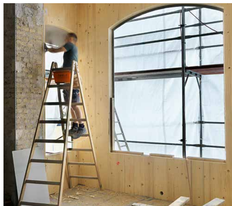
◀ Der Erker wurde in Brettsperrholzbauweise erneuert
